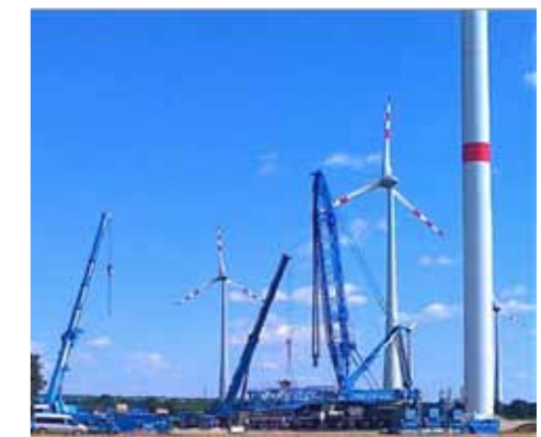
Foto 4: Bauplatz für die Schwerstrakre – Fotoarchiv Alpenverein Molln - Steyrtal
