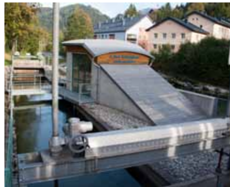
Ein Großteil der Lunzer Haushalte bezieht seinen Strom aus der Wasserkraftschnecke, die mitten im Ort an der Ois eingebaut ist.
