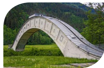
In dieser Dökerbrücke überquert die Wasser-Zuleitung für das Kraftwerk Opponitz die Ybbs.
